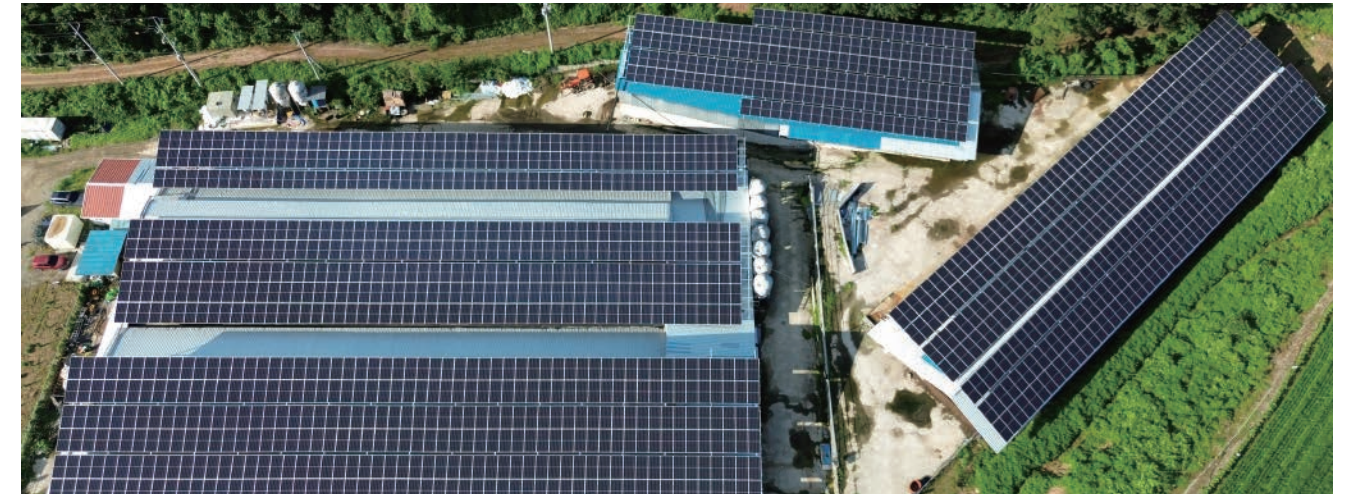
Coréia Data de instalação: 2024
