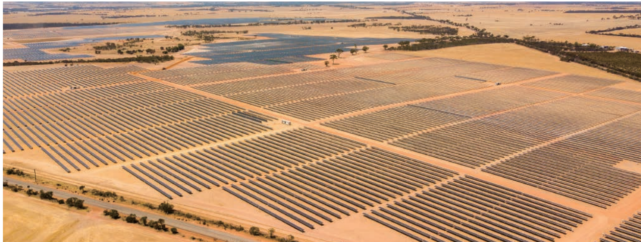
Austrália Data de instalação: 2020
